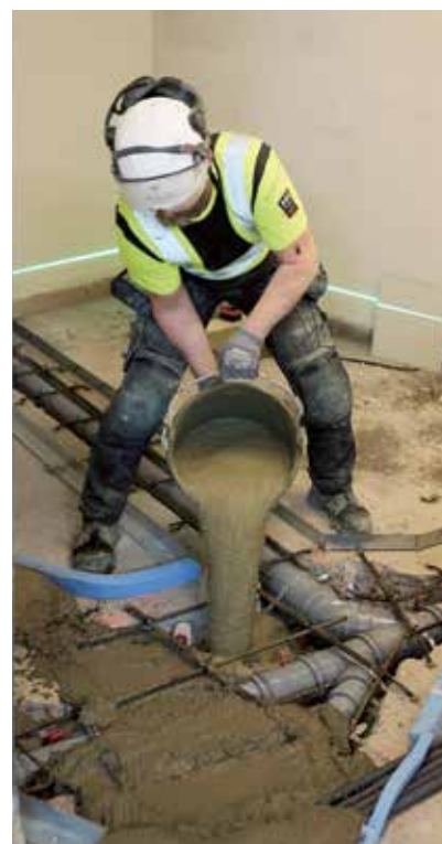
Vår snickare Tomasz gjuter in nya avloppsrör i cement där den tillgängliga toaletten kommer att finnas.
