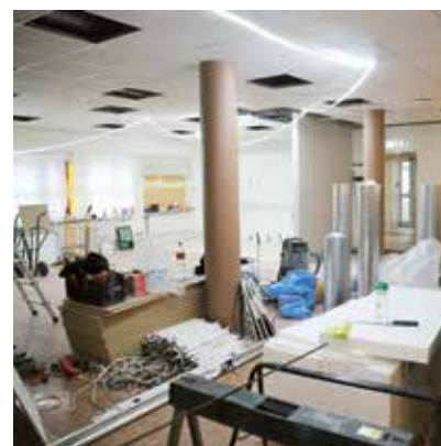
Här byggs den nya cafédelen.
